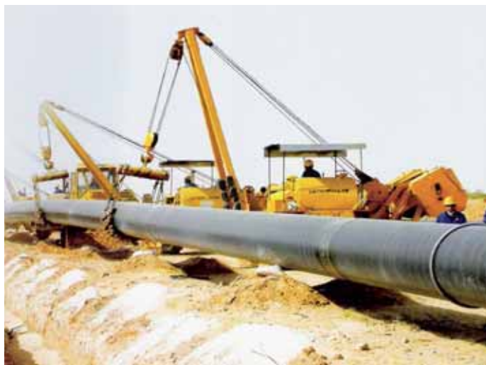
42.10 Κατασκευή αγωγού φυσικού αερίου
