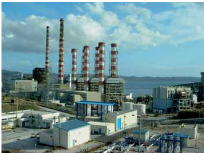
42.7 Λαύριο: θερμοηλεκτρικός σταθμός Δ.Ε.Η.
