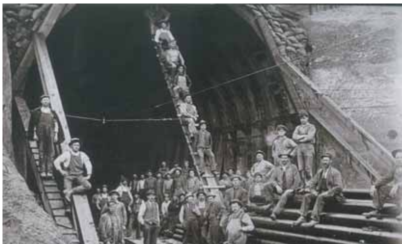
31.5 Ντιρτίτ, Η.Π.Α.: Ηπειρώτες μαστόροι σε εργασίες κατασκευής σιδηροδρομικής γραμμής το 1927
