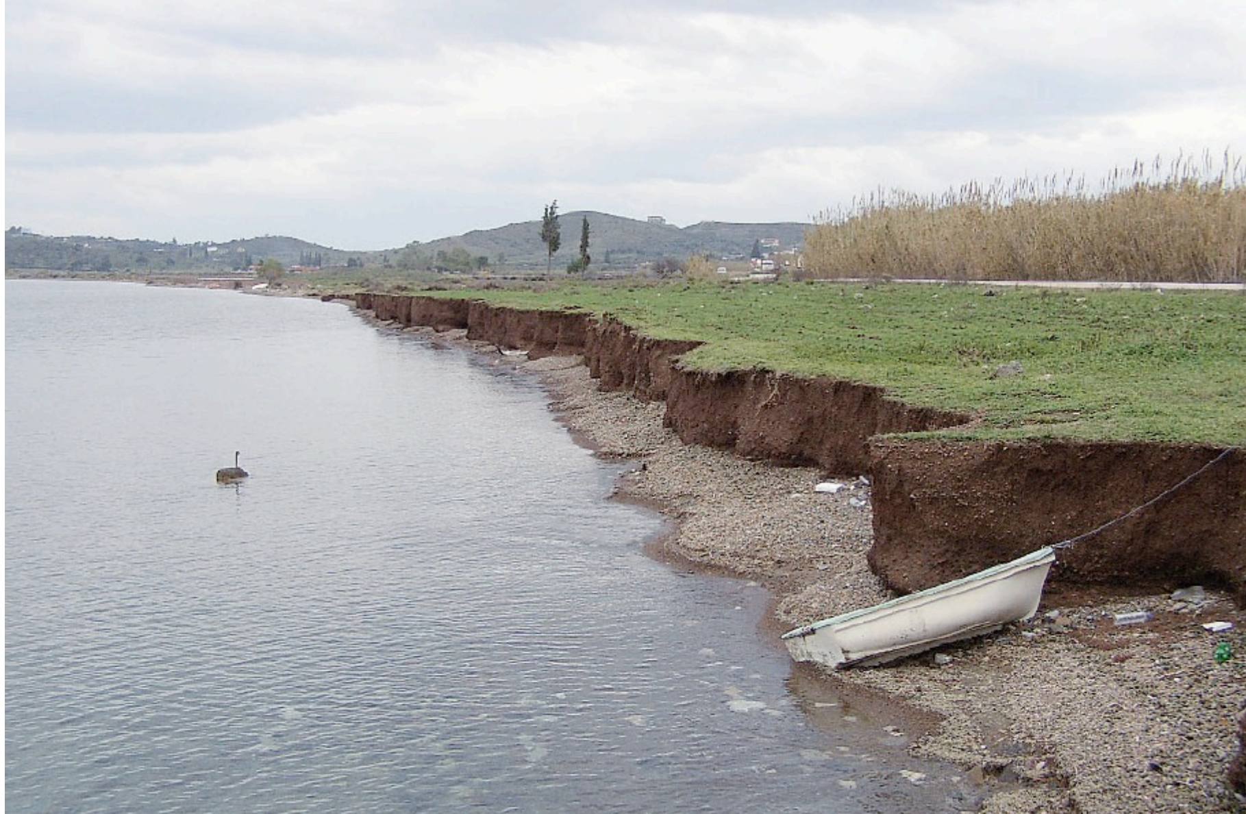
Φωτο 14.1 Υποχώρηση της ακτογραμμής λόγω διάβρωσης σε ακτή του Αργολικού κόλπου, Πόρτο Χέλι, Αργολίδα. Φαίνεται ο στύλος που χρησιμοποιούταν για το δέσιμο των πλοιαρίων που λόγω της υποχώρησης της ακτογραμμής σήμερα βρίσκεται περίπου 4 m μέσα στη θάλασσα.
