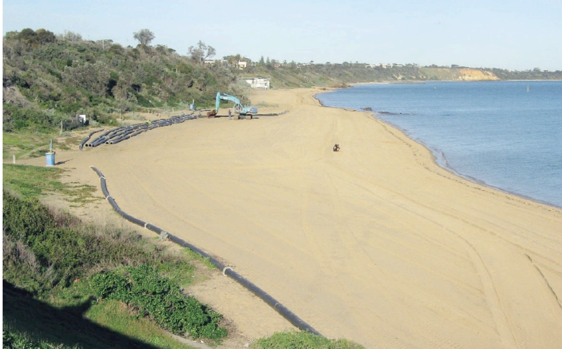
Φωτο 14.9 Τεχνητός εμπλουτισμός αιγιαλού (beach nourishment) με ίζημα που μεταφέρεται από άλλη περιοχή μέσω αγωγών στα παράκτια περίχωρα της Μελβούρνης (Melbourne), Victoria, Australia. Η τεχνική αυτή μέθοδος για την προστασία των ακτών από τη διάβρωση είναι πολύ δημοφιλής στο παράκτιο αυτό τμήμα της Victoria.
