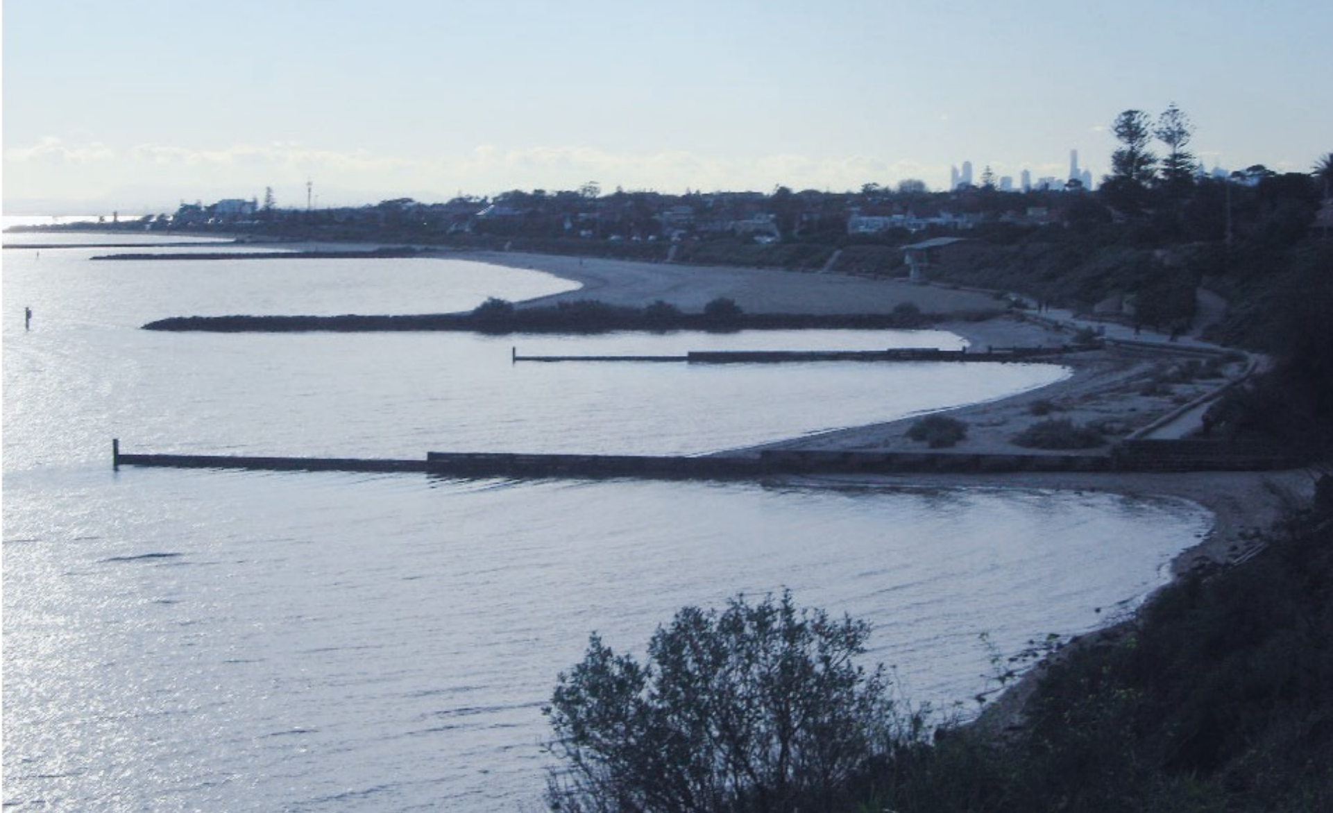
Φωτο 14.8 Σειρά προβόλων (groins) για τη διατήρηση του ιζήματος τεχνητά τροφοδοτούμενων αιγιαλών στην περιοχή Sandringham Harbour, Melbourne, Victoria, Australia. Το ίζημα συσσωρεύεται στην πλευρά που το παράκτιο ρεύμα συναντά τους βραχίονες σχηματίζοντας έτσι έναν ανώμαλο αιγιαλό μεγάλου πλάτους.
