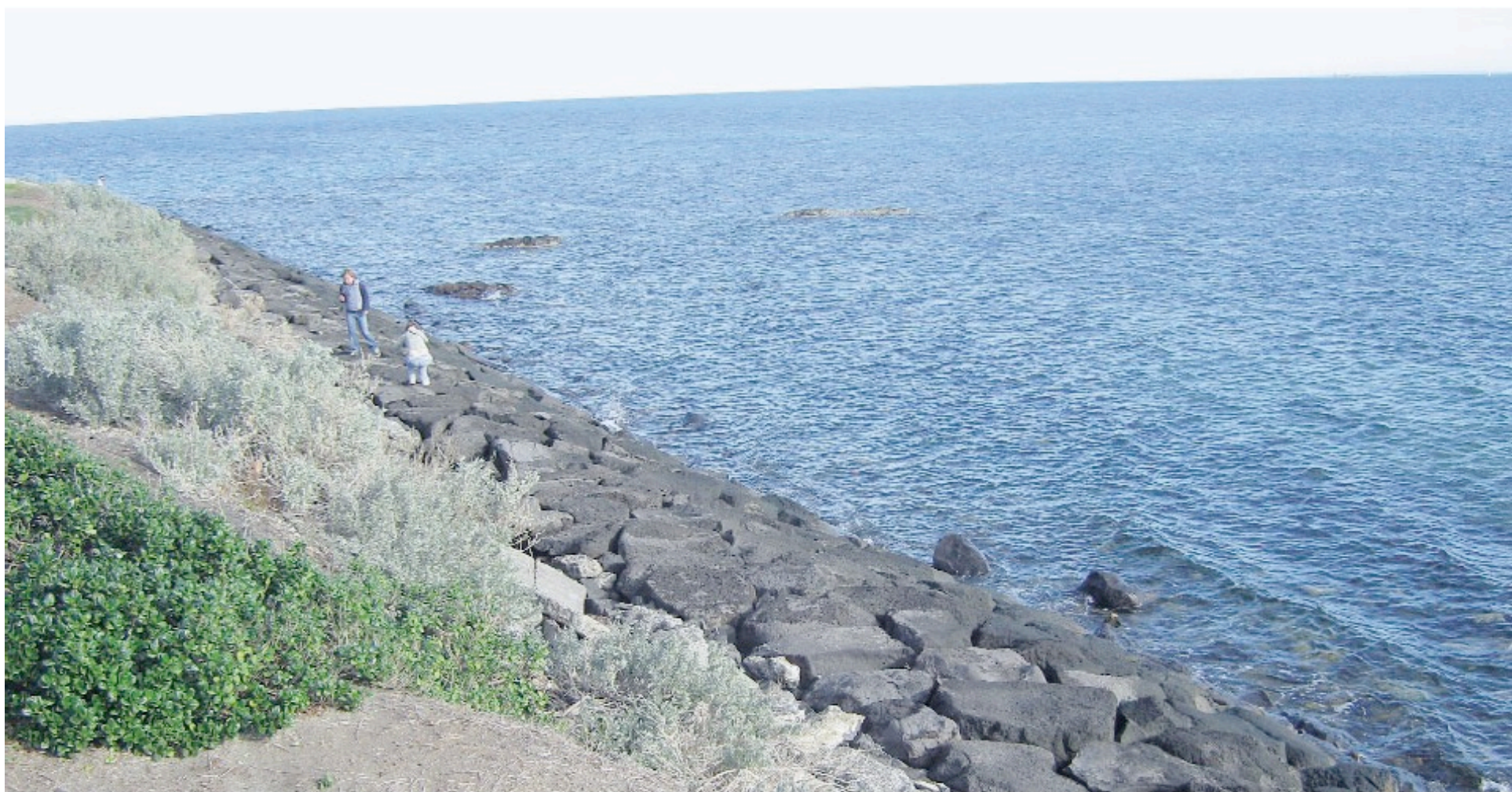
Φωτο 14.2 Τοίχος (seawall) κατασκευασμένο από ηφαιστειακούς ογκόλιθους για την προστασία από τη θαλάσσια διάβρωση στην περιοχή Green Point στο παράκτιο μέτωπο των περχώρων της πόλης Melbourne, Victoria, Australia.
