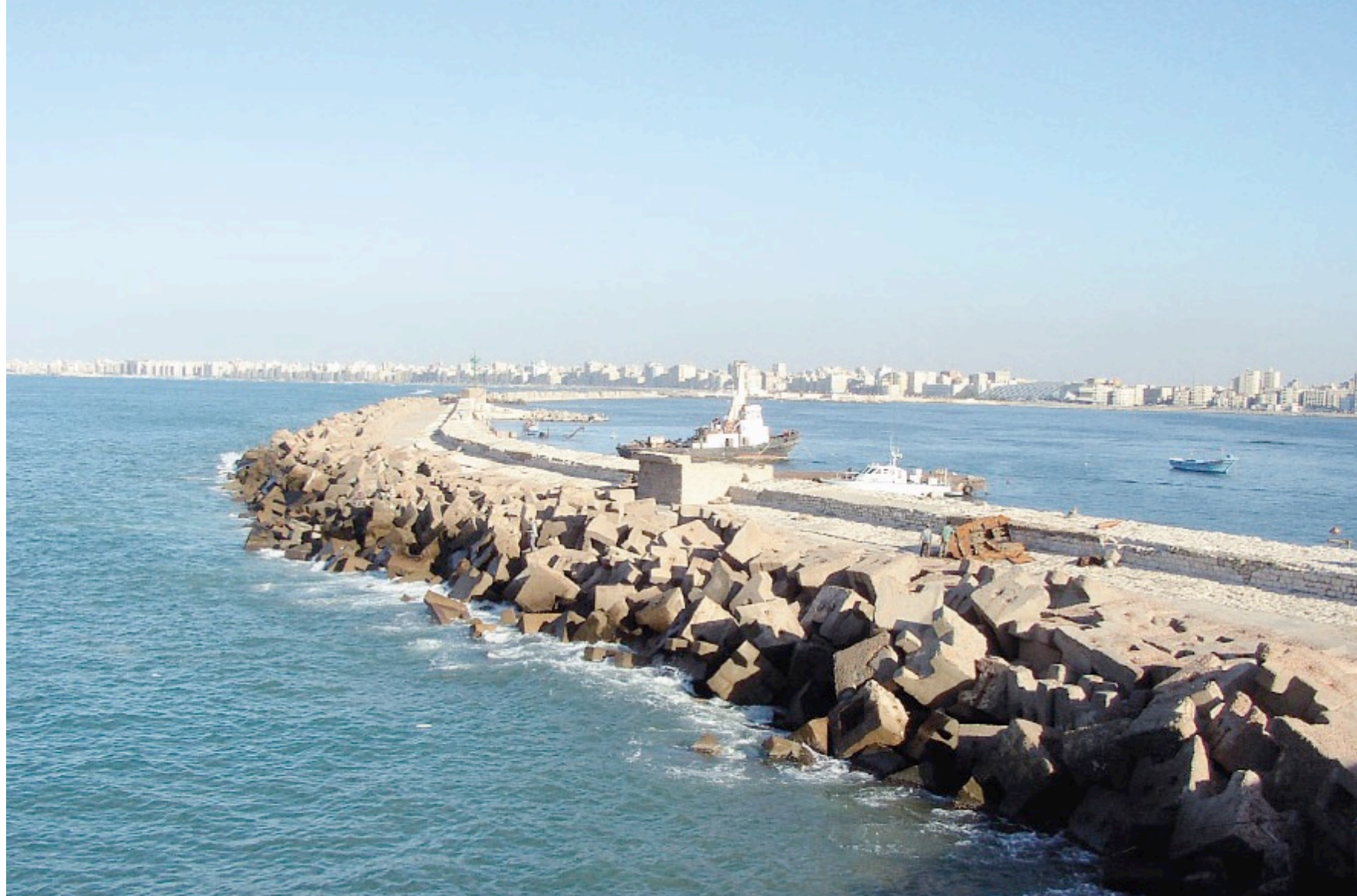
Φωτο 14.4 Κυματοθραύστης (breakwater) από γωνιώδη τεμάχια σκυροδέματος για την προστασία τμήματος της πόλης Alexandria, Egypt.
