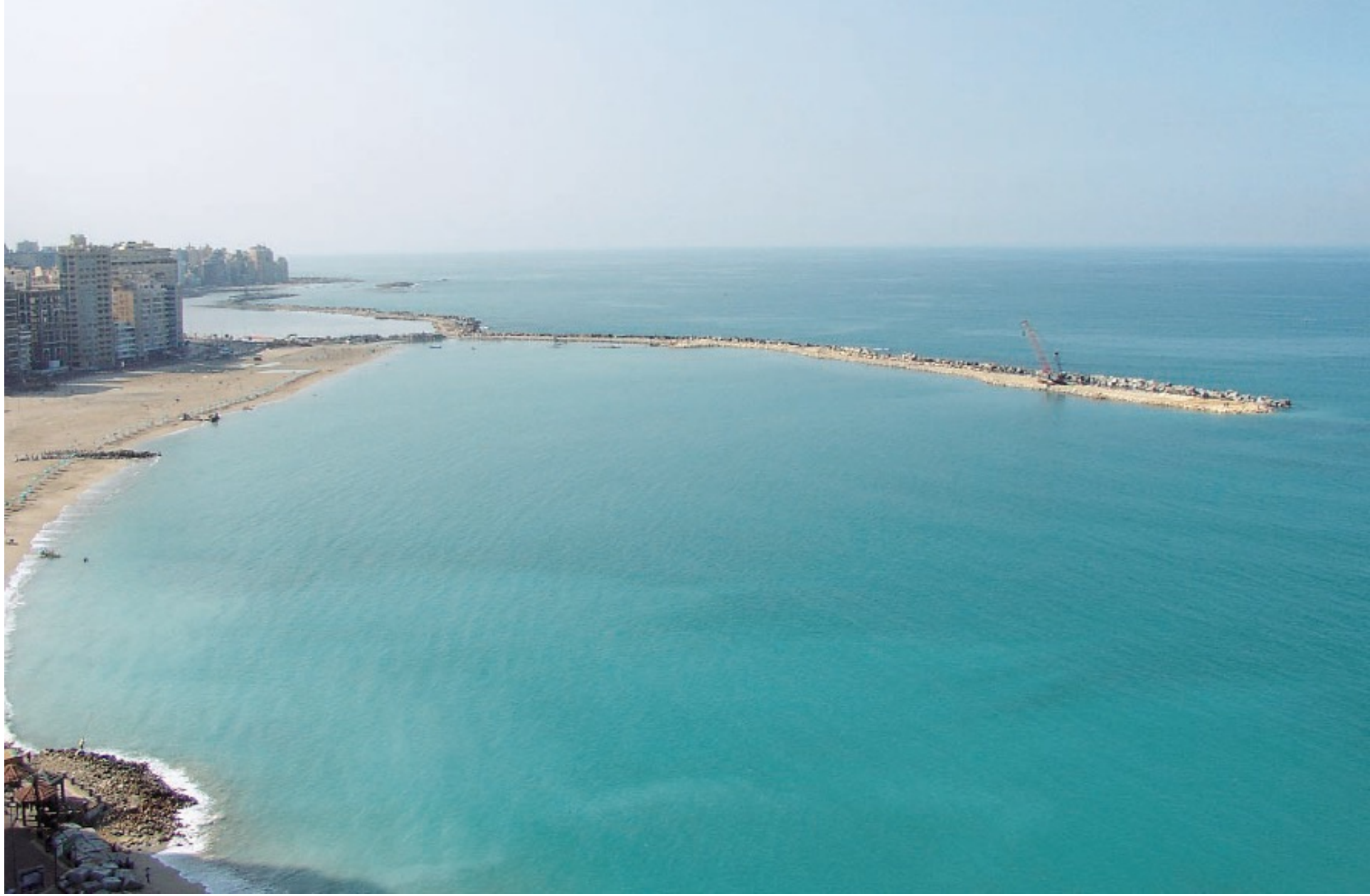
Φωτο 14.6 Κυματοθραύστης (breakwater) ενωμένος στο ένα άκρο με την ακτή για την προστασία από τη δράση του κυματισμού αιγιαλού της πόλης Alexandria, Egypt.
