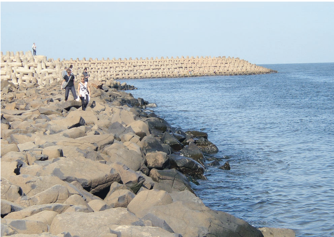
Φωτο 9.8 Προσπάθειες διατήρησης της δελταϊκής ακτογραμμής και των εκβολών του ποταμού Νείλου στη θέση Rosetta, Egypt. Τα προβλήματα υποχώρησης του δέλτα εντάθηκαν μετά την κατασκευή του φράγματος του Aswan.
