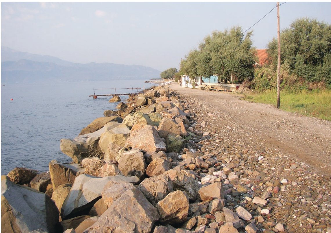
Φωτο 9.9 Προσπάθειες περιορισμού της διάβρωσης του δέλτα του Μόρνου στην περιοχή ανατολικά των παλαιών εκβολών του ποταμού. Η διάβρωση εντάθηκε μετά την κατασκευή και λειτουργία του φράγματος στον άνω ρου για την υδροδότηση της Αθήνας.
