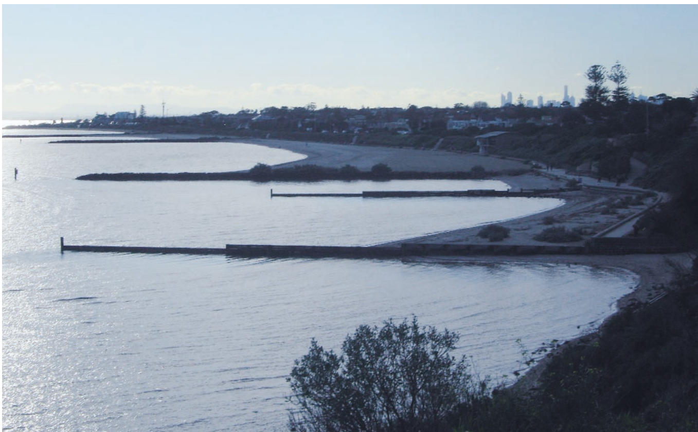
Φωτο 14.8 Σειρά προβόλων (groins) για τη διατήρηση του ιζήματος τεχνητά τροφοδοτούμενων αιγιαλών στην περιοχή Sandringham Harbour, Melbourne, Victoria, Australia. Το ιζημα συσσωρεύεται στην πλευρά που το παράκτιο ρεύμα συναντά τους βραχίονες σχηματίζοντας έτσι έναν ανώμαλο αιγιαλό μεγάλου πλάτους.
