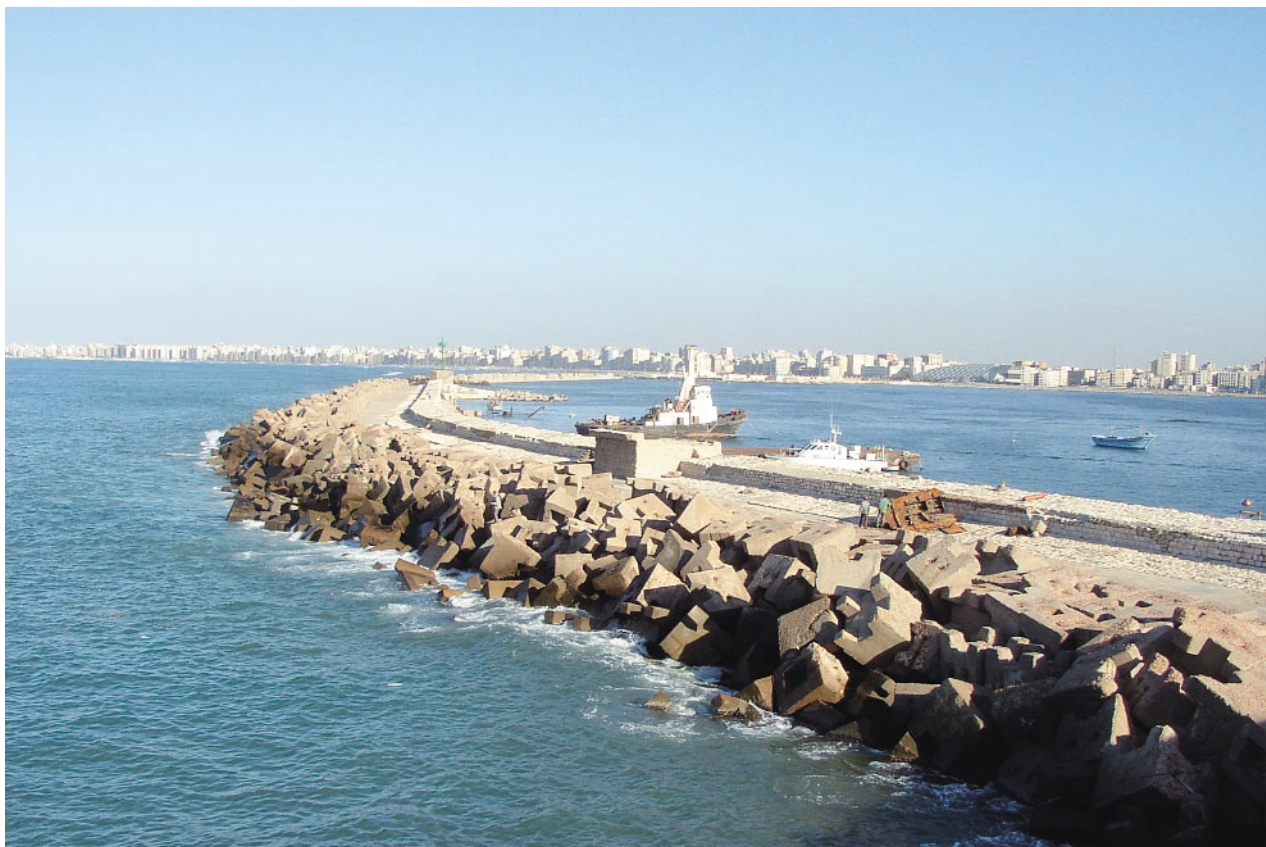
Φωτο 14.4 Κυματοθραύστης (breakwater) από γωνιώδη τεμάχια σκυροδέματος που έχει κατασκευαστεί για την προστασία τμήματος της πόλης Alexandria, Egypt.
