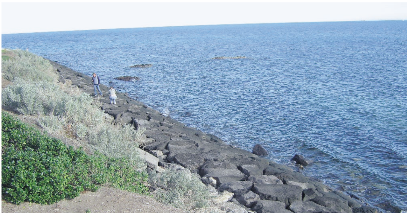
Φωτο 14.2 Τοίχος (seawall) κατασκευασμένο από ηφαιστειακούς ογκόλιθους για την προστασία από τη θαλάσσια διάβρωση στην περιοχή Green Point στο παράκτιο μέτωπο των περιχώρων της πόλης Melbourne, Victoria, Australia.
