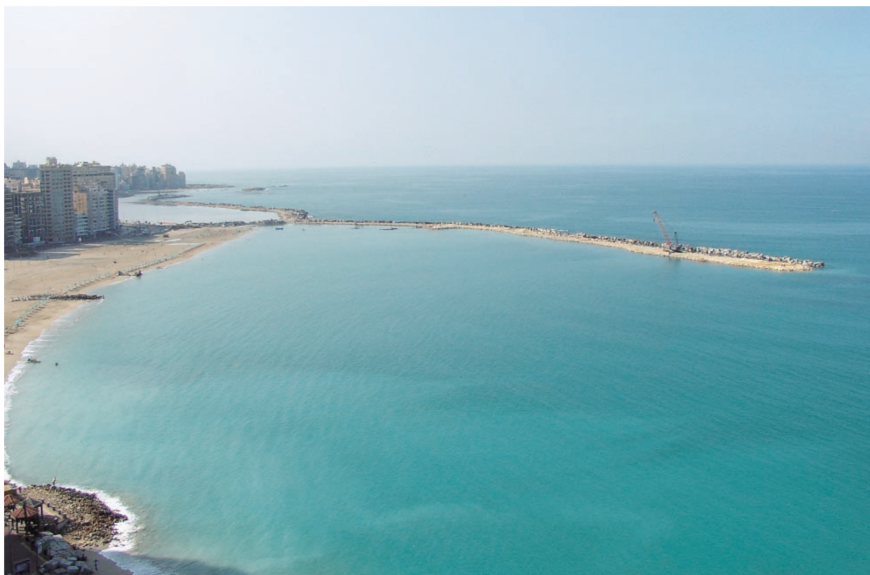
Φωτο 14.6 Κυματοθραύστης (breakwater) ενωμένος στο ένα άκρο με την ακτή κατασκευασμένος για την προστασία από τη δράση του κυματισμού αιγιαλού της πόλης Alexandria, Egypt.
