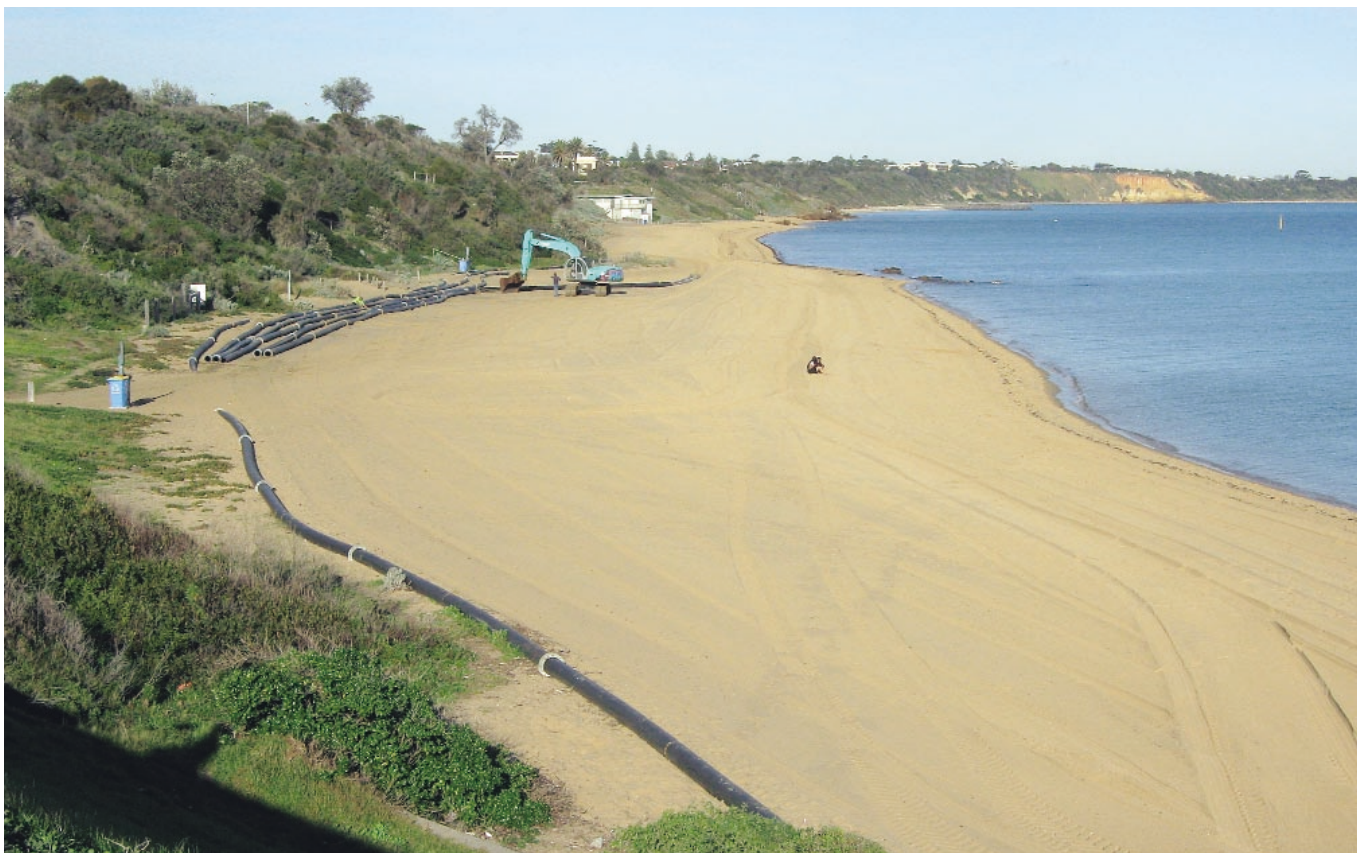
Φωτο 14.9 Τεχνητός εμπλουτισμός αιγιαλού (beach nourishment) με ιζημα που μεταφέρεται από άλλη περιοχή μέσω αγωγών στα παράκτια περίχωρα της Μελβούρνης (Melbourne), Victoria, Australia. Η τεχνική αυτή μέθοδος, για την προστασία των ακτών από τη διάβρωση, είναι πολύ δημοφιλής στο παράκτιο αυτό τμήμα της Victoria.
