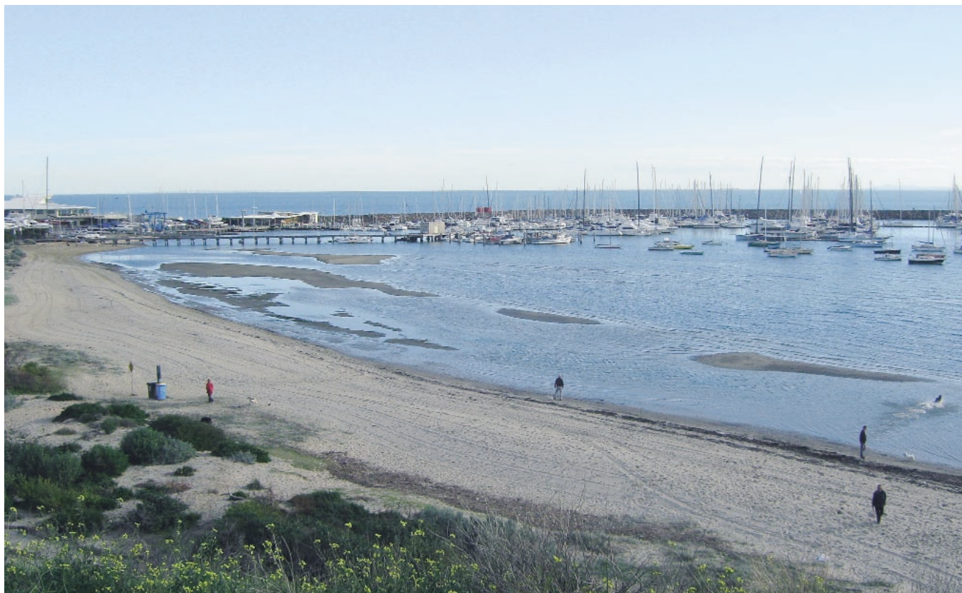
Φωτο 14.5 Κυματοθραύστης (breakwater) που έχει κατασκευαστεί για τον ελλιμενισμό σκαφών, Sandringham Harbour, Melbourne, Victoria, Australia. Το επίμηκες παράκτιο ρεύμα είναι από τα δεξιά προς τα αριστερά (στην φωτο) και η αλληλεπίδρασή του με την κατασκευή έχει οδηγήσει στην απόθεση ιζήματος κατά μήκος του προστατευόμενου τμήματος της ακτογραμμής.
