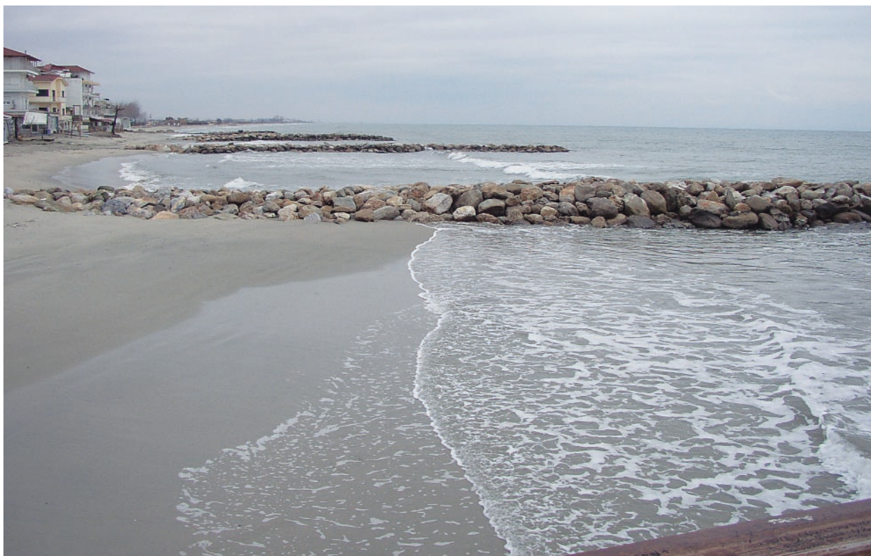
Φωτο 14.7 Πρόβολοι (groins) που έχουν κατασκευαστεί για την προστασία του αμμώδους αιγιαλού της Παραλίας Κατερίνης, Πιερία.
