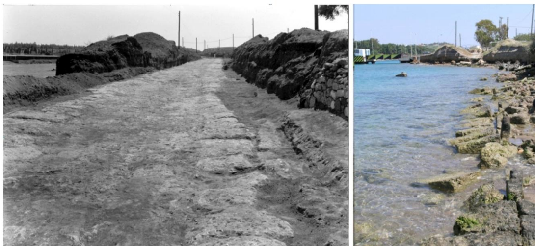
Φωτογραφίες που τραβήχτηκαν το 1960 (αριστερά) και το 2006 (δεξιά) στο δυτικό άκρο του Δίοικου. Η υποχώρηση των ακτών και του Δίοικου είναι εμφανής.
